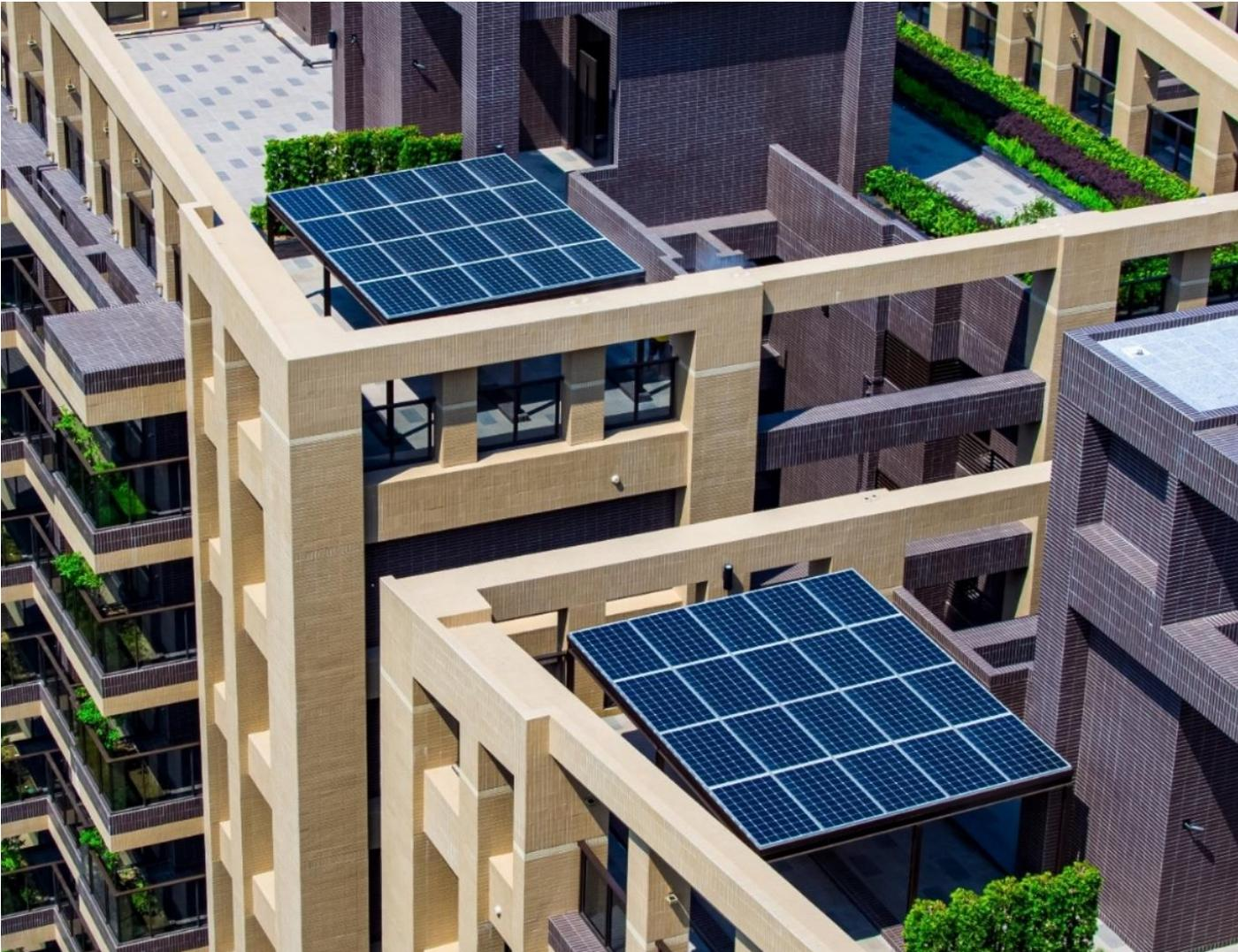
永信建設將太陽能發電系統納入住宅商品的規劃設計當中，圖為翡翠流域頂樓太陽能系統架設情形，能源規模為 32.32 瓩，太陽能板在頂樓架起遮陽隔熱的複合式空間，可供社區民眾進行曬衣、休憩等使用。
